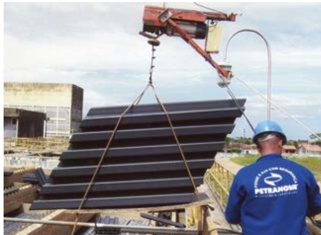
Instalação de perfis Petranova® em uma E.T.A. da Casal em Maceió/AL
