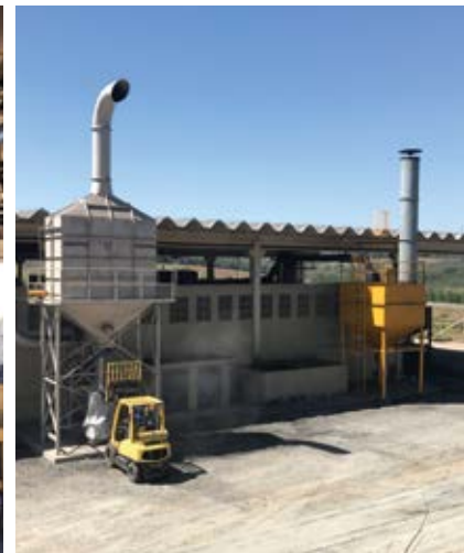
Sistema de despoeiramento
