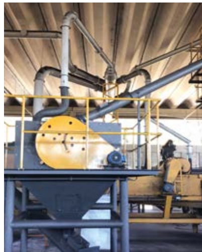
Britagem e rebritagem de carvão antracito
